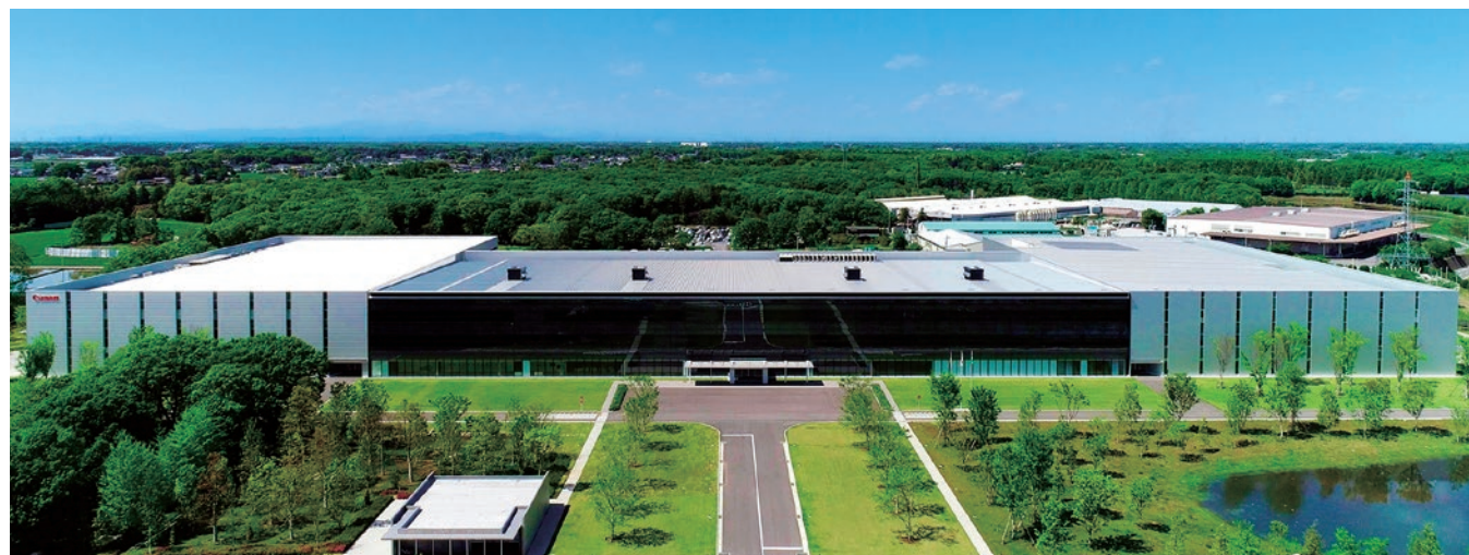
佳能环保科技园（茨城县坂东市）
