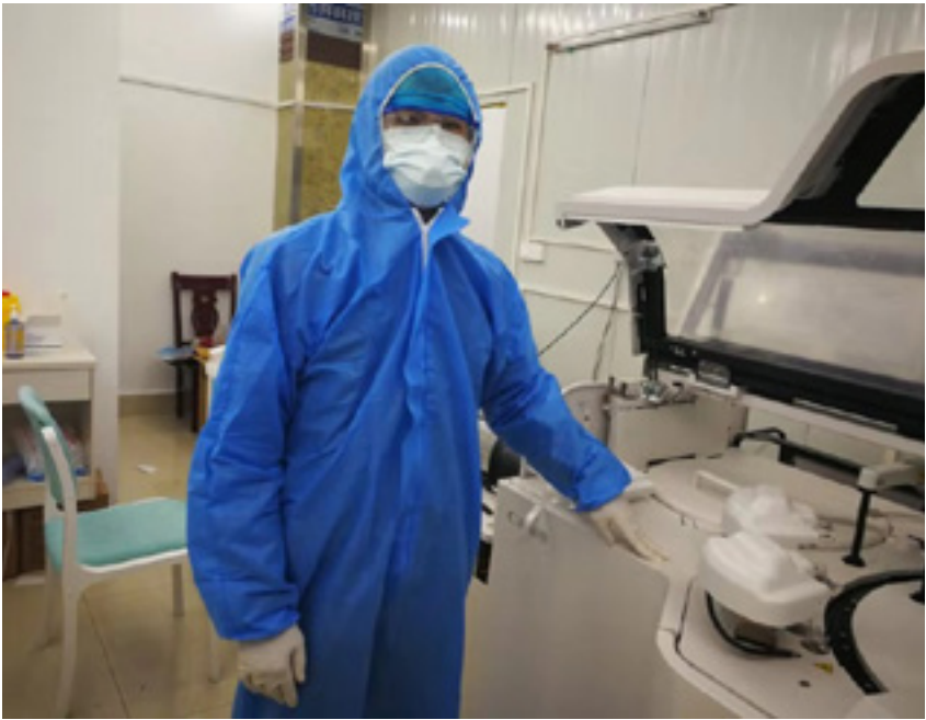
佳能医疗维修部员工在河南信阳市潢川县人民医院安装生化检测设备
